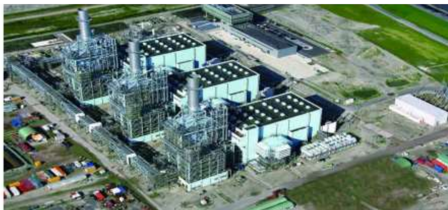
Vattenfall's Magnum GTCC power plant
