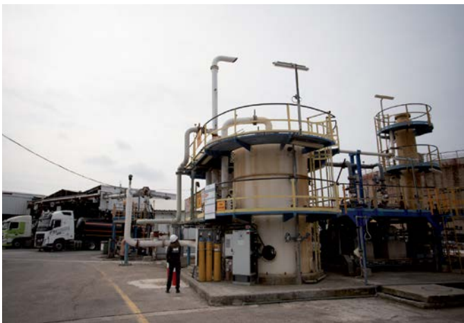
בזן: מתקן להשבת אדים (VRU). בעת מילוי מיכליות כביש, המפחית פליטות של חומרים אורגניים נדיפים ובפרט בזן בשיעור של כ-83%
