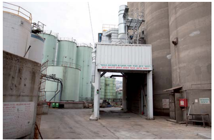
שמן תעשיות שמנים בע"מ: עמדת קליטת חומרי גלם שנסגרת בעת הפריקה ומעליה מתקן ציקלון להפחתת פליטות החלקיקים בעת הפריקה
