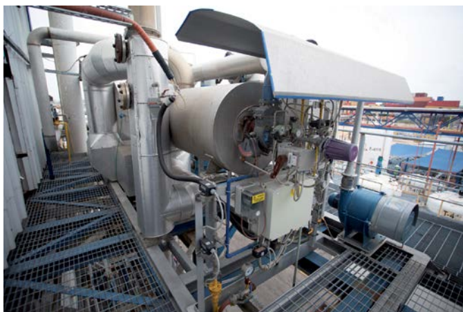
דור: מחמצן טרמי (CTO) על מתקן מיחזור הממסים. מפחית כ-85% מפליטות חומרים אורגניים נדיפים
